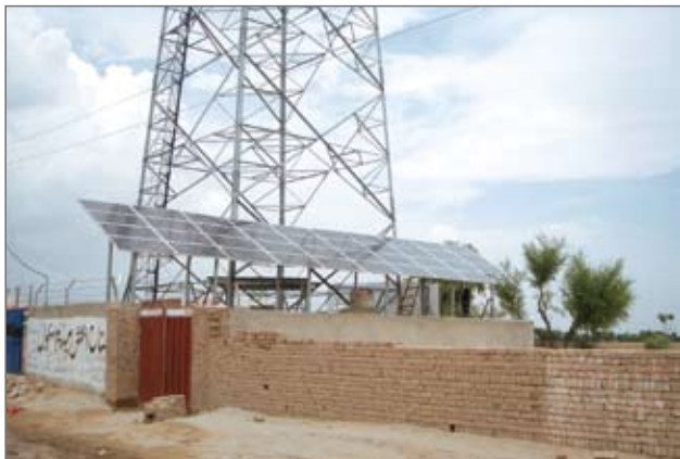
图3 光伏市电混合供电站点外观
